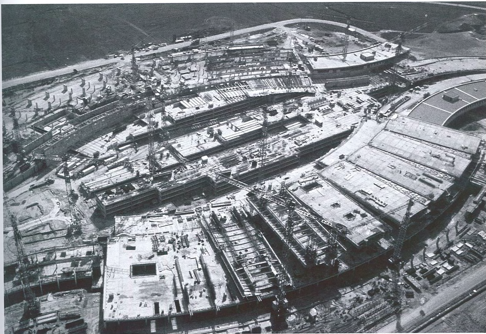
Chantier, septembre 1979. La mise en place des coques du toit.
