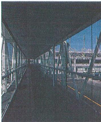
tubulaires blancs qui offrent ainsi en façade un abondant linéaire de mâts de pavage. Cette structure pyramidale en acier prend appui de part et d'autre sur deux étroits bâtiments linéaires en béton qui accueillent les commerces côté ville et, côté piste, les galeries d'embarquement et différents locaux techniques.
