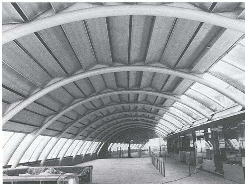
Aérogare n° 2 à Roissy-en-France 8 Couverture en caissons de section elliptique. 9 Salle d'embarquement dans le module pour trafic moyen courrier. 10 et 11 Viaduc d'accès. (Photos Jean-J. Moreau.)
