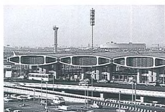
La structure modulaire des coques de l'Aérogare 2 avec, à l'arrière-plan, la tour de contrôle et l'Aérogare 1.
