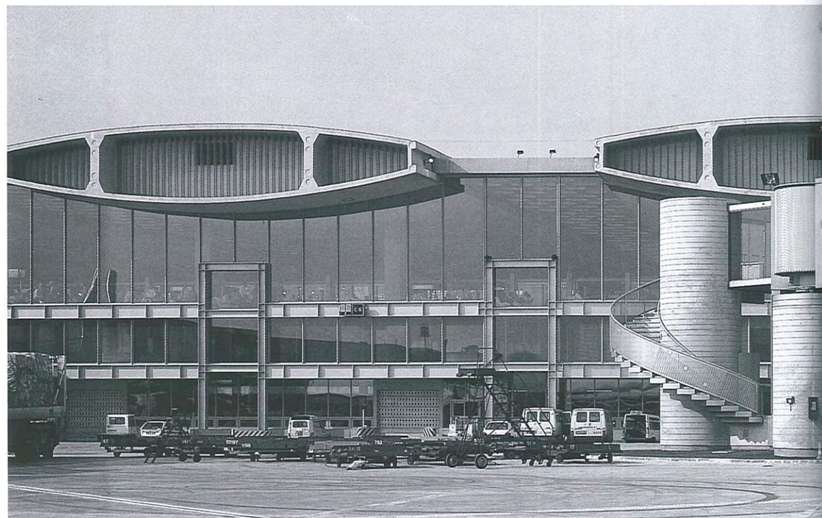
A l'opposé des Halls A, B et D, les coques du Hall C, plus hautes, ont été coulées en place.
