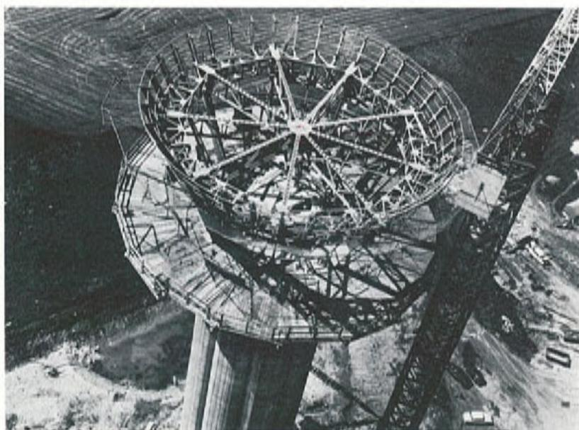
Cette vue aérienne révèle l'ordonnance de la charpente métallique sommant la tour : 9 portiques rayonnants noués au centre et chaînés par autant de poutres en treillis. On remarquera, sur l'extrados des poutres, les connecteurs soudés qui les associeront à la dalle creuse en béton armé de la terrasse portant le local radar.
