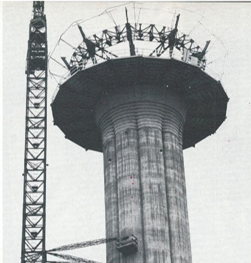
Pareil à une fleur qui s'épanouit, le fût, couronné de son encorbellement, s'est agrémenté d'un platelage métallique en porte à faux qui supporte la plate-forme fixe de travail pour l'exécution de la vigie, dernière phase de la construction.
