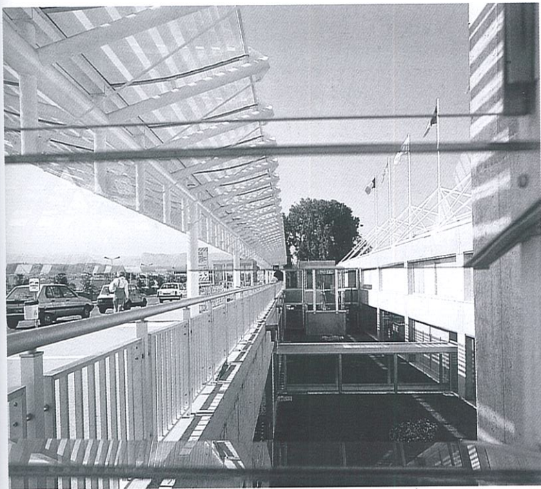
Vue du «canyon» depuis le niveau des départs.
