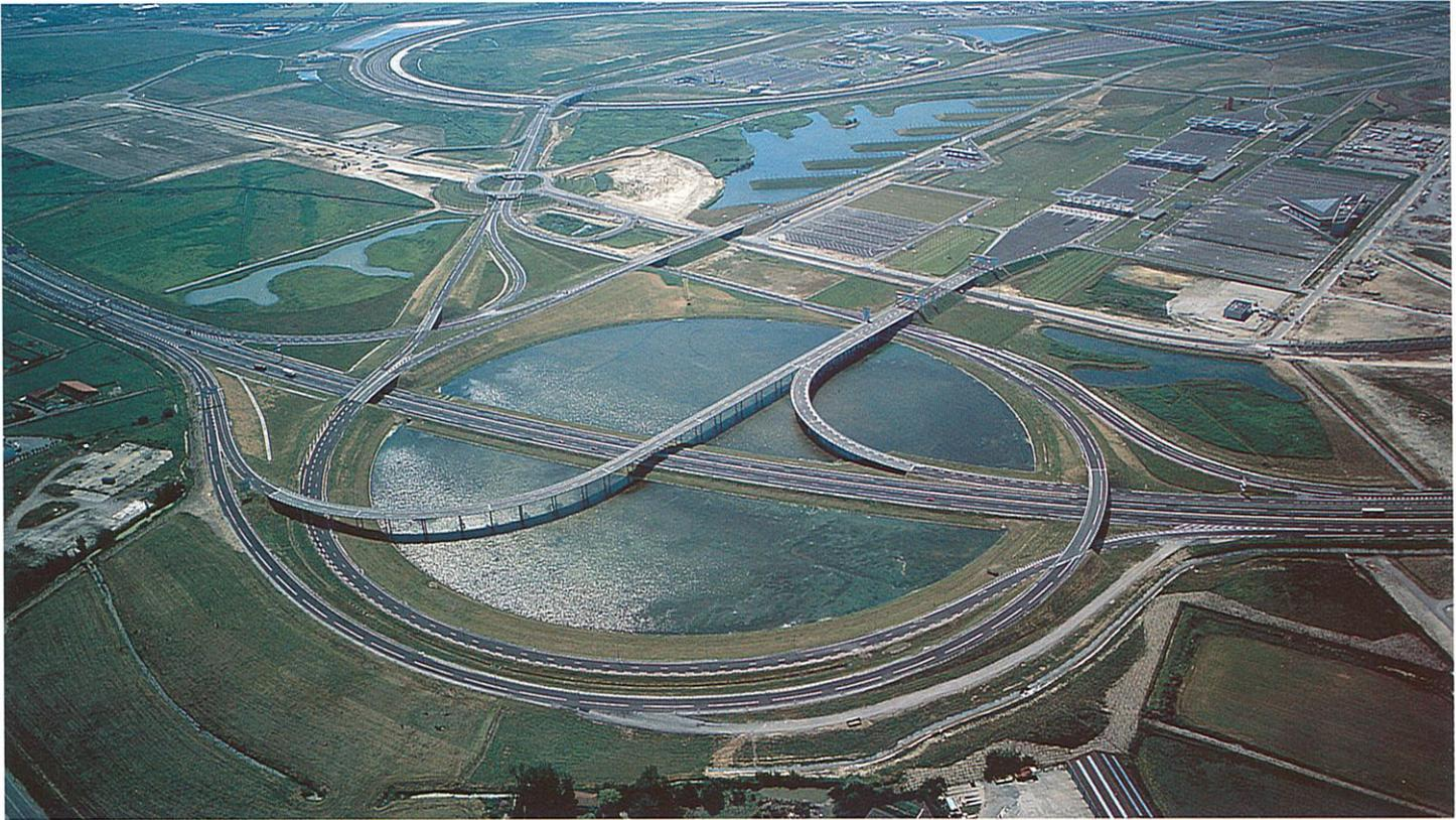
L'accès principal est l'échangeur de Fort-Nieulay, composé de viaducs surplombant un lac de 400 m de diamètre. A cet échangeur sont séparés les véhicules de tourisme des poids lourds.
