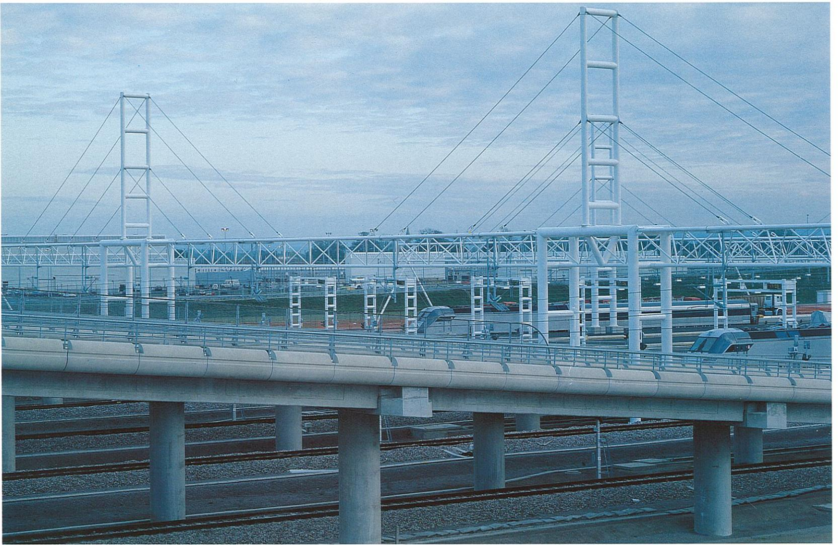
La zone des quais. Après le franchissement des péages et des contrôles frontaliers français et britanniques (structures à auvents), les véhicules sont orientés vers la zone d'embarquement. Celle-ci comprend huit quais de 1 km de long, desservis par deux viaducs d'accès et deux viaducs de sortie. Les structures haubanées blanches qui supportent les caténaires et l'éclairage sont les repères les plus visibles à l'approche du Terminal.
