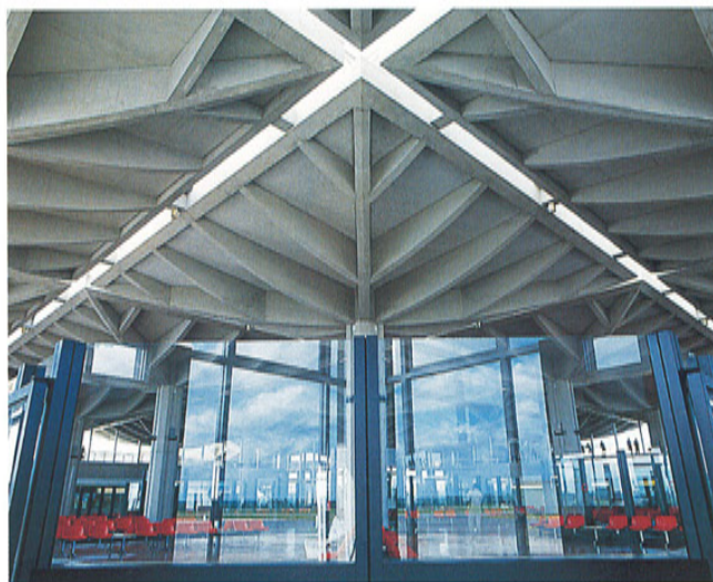
La structure présente des degrés de complexité visuelle très variables selon l'angle sous lequel on la regarde.
