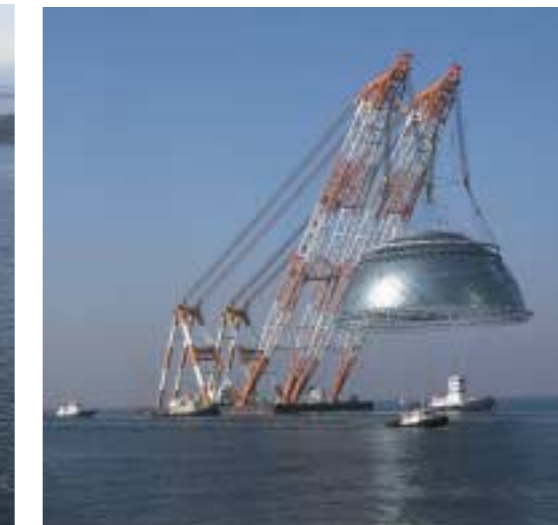
(d) The dome lifted from the barge.
