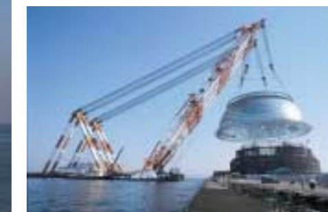
(d) The dome lifted from the barge.
