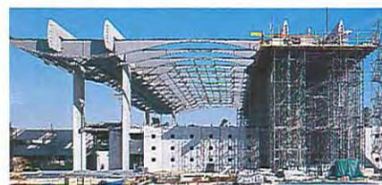
Chantier. L'ossature principale de la toiture est constituée de huit paires de poteaux en béton, porteurs de quatre bipoutres de 80 m de long. La toiture et ses supports ont exigé un travail fin et précis du béton, mais aussi un mode d'association très performant du métal et du béton.
